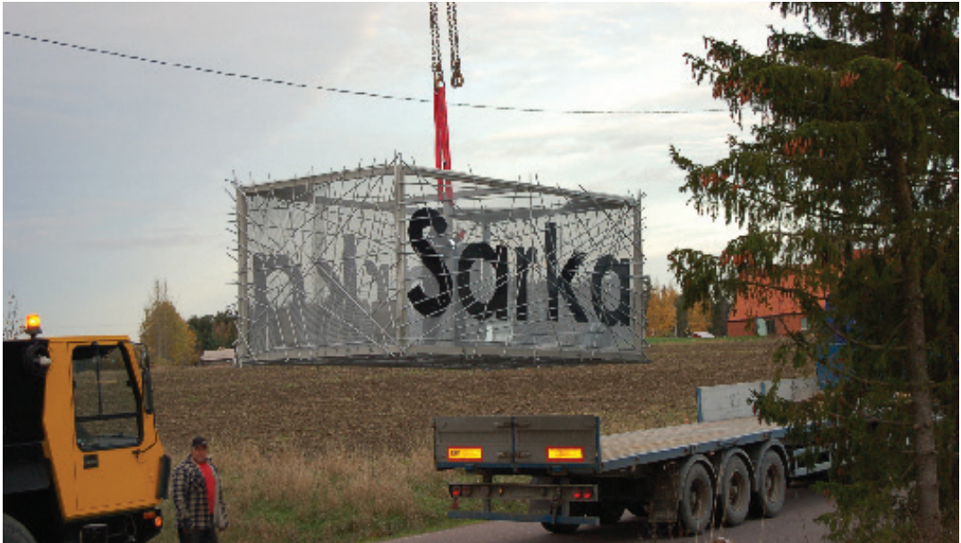
Saran maamerkin paaliosaa nostetaan laitettavaksi teräskorsien päälle. Kuva: Aarno Aittamäki
