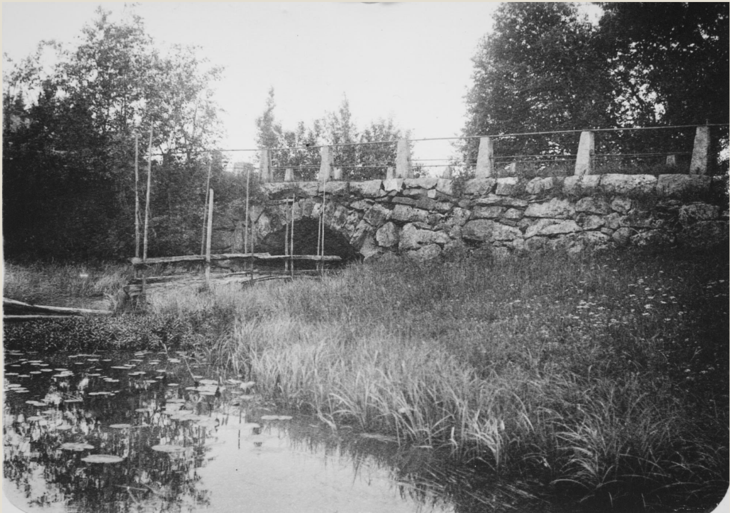
Vanha Onkijoen yli kulkenut silta.
