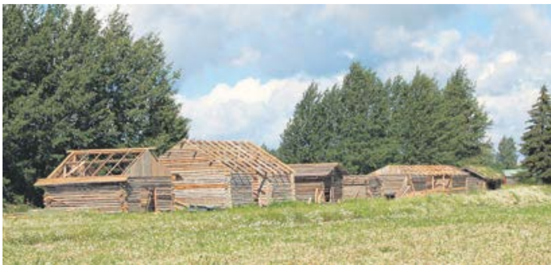
Lato joka maakunnasta -hanke toi maatalousmuseon pihamaalle näyttävän latojen rivistön. Kuvassa latojen katot rakenteilla heinäkuussa 2006. Kuva: Tanja Altti.
