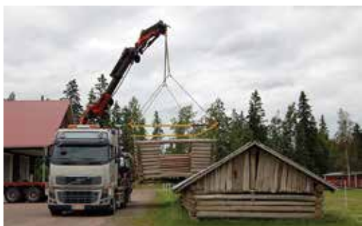
Kesällä 2013 museolle lahjoituksena saatu lato siirrettiin Urjalasta Loimaalle kahdessa osassa.
