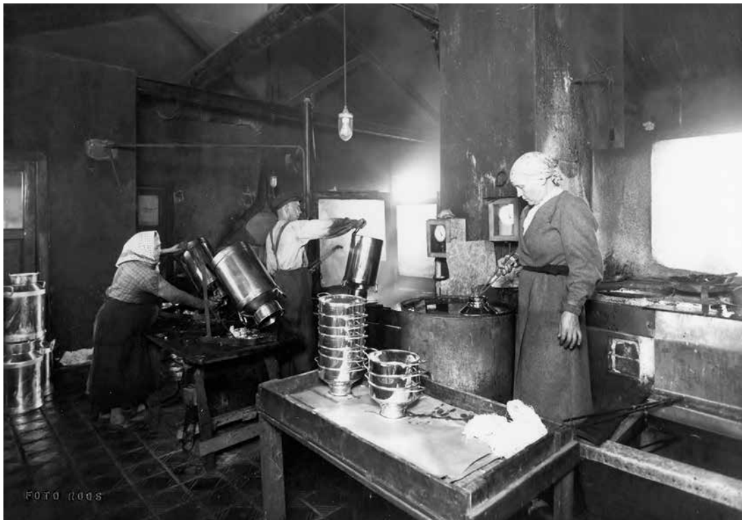
Maitotonkat upotettiin tinaliukseen. Menetelmä oli opittu tanskalaisilta. Tinaamossa työskentelivät vuonna 1939 Laura Åhs, Väinö Helander ja Maria Eronen. Kuva: Foto Roos / Carlanderin suvun arkisto.
