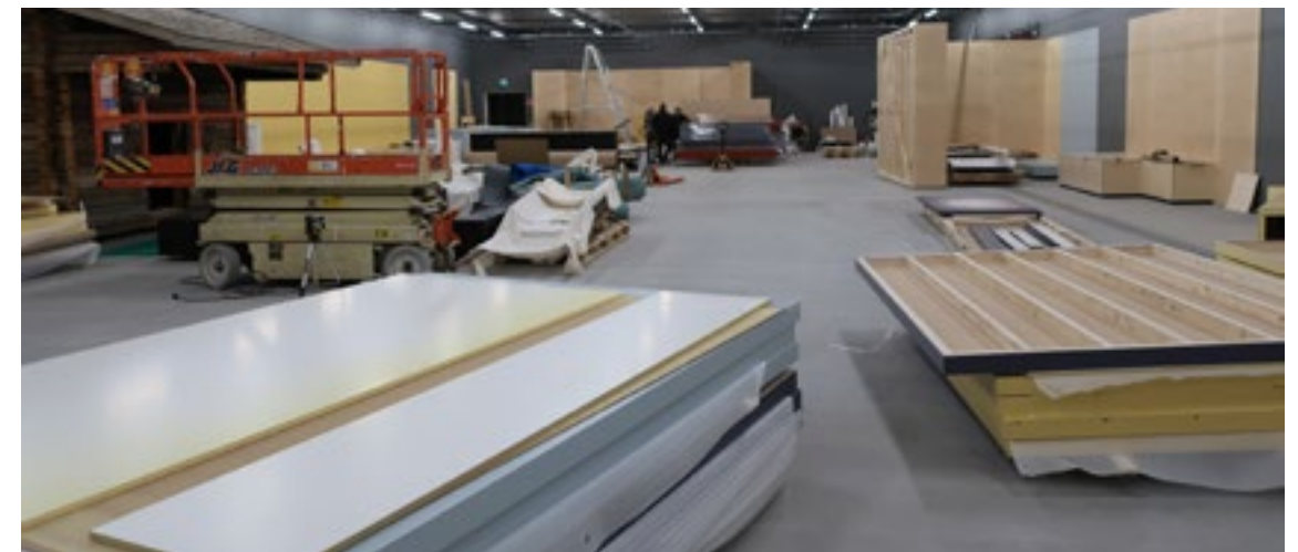
Näyttelytila rakenteilla uuteen Viikki-halliin. Kuva: Elsa Hietala.
