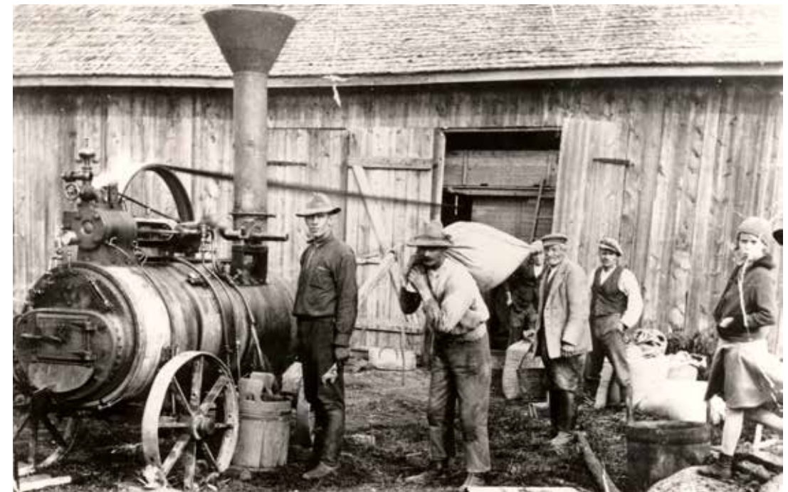
Puintia höyrykoneen käyttämällä puimakoneella. Kuva: Eurajoen maatalousmuseo.
