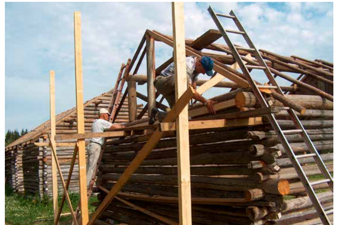
Saran latorivistön ladot siirrettiin paikalleen hankevaroin ja pystytettiin talkoovoimin. Kuva: Tanja Toukola.
