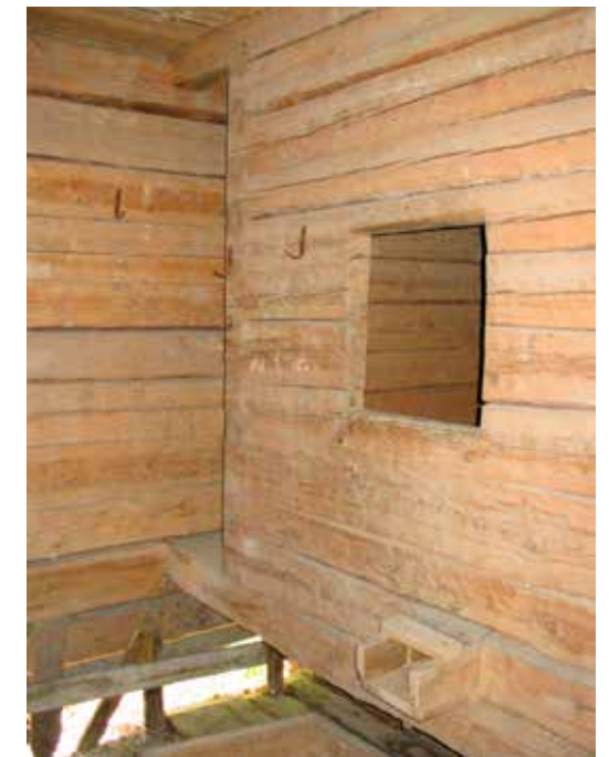
Seinästä irrallaan oleva laarirakenne aitassa. Kuva: Aarno Aittamäki.
